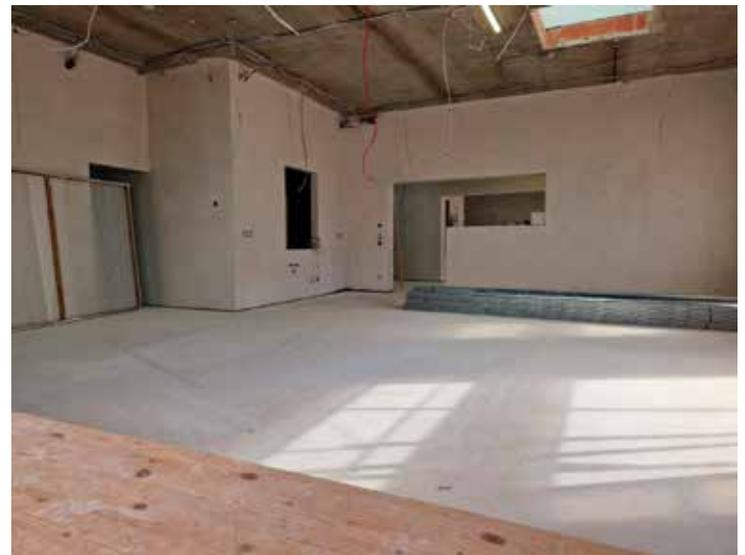
Innenansicht: Die Wände sind fertig verputzt, Malerarbeiten sowie Boden- und Fliesenleger sind die nächsten Gewerke, die für die Fertigstellung verantwortlich sind.
