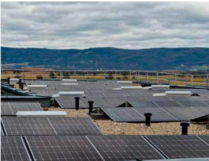
Das Dach ist mit PV-Modulen ausgestattet. Die Anlage ist für 60 kWp ausgerichtet, was deutlich mehr als der Eigenbedarf ist. Der Rest wird in das Netz bzw. die Energiegemeinschaft eingespeist.
