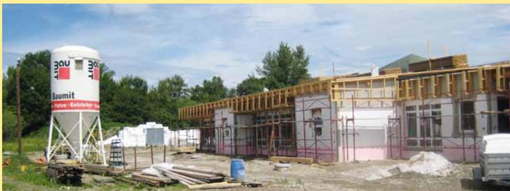
Der Kindergarten-neubau in der Augasse schreitet zügig voran. Der Rohbau ist fertiggestellt, die Fenster eingebaut, der Dachstuhl sitzt, die Dämmung wird gerade angebracht. Auch die Heizungs-installation ist bereits abgeschlossen.
