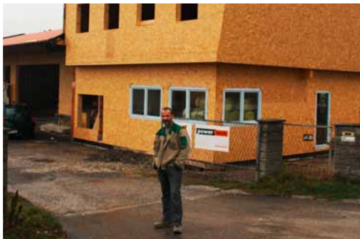
Unternehmer Jürgen Brandstätter vor seinem künftigen Firmensitz in Haderswörth.
